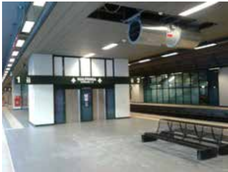
JFC installed in an airport/ Instalación de un JFC en un aeropuerto
